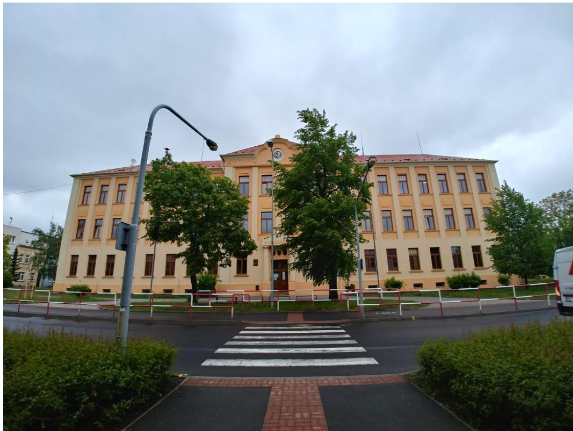
Po rekonstrukci – jaro 2019
