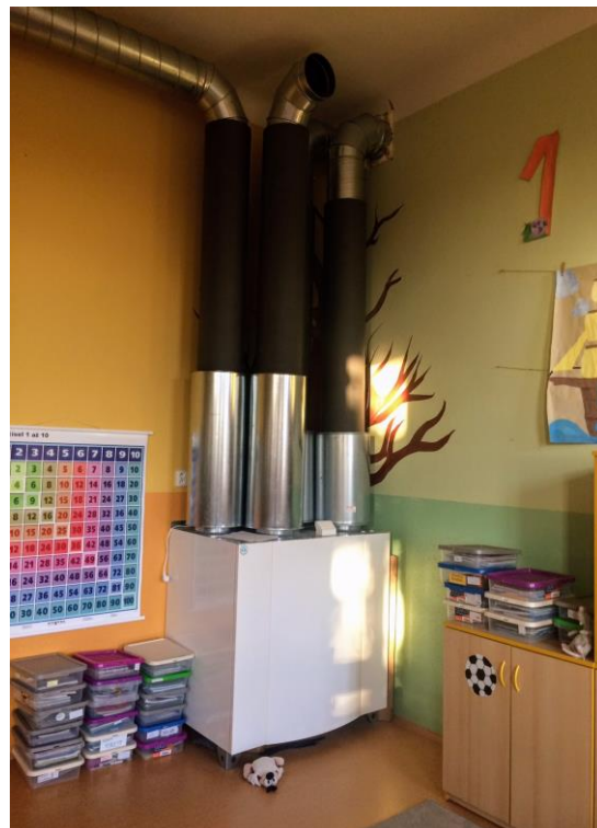
Ještě nezakryté rekuperační potrubí na chodbě a jednotka ve třídě č. 9
