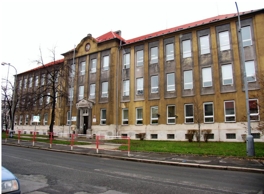
Před rekonstrukcí – jaro 2018
