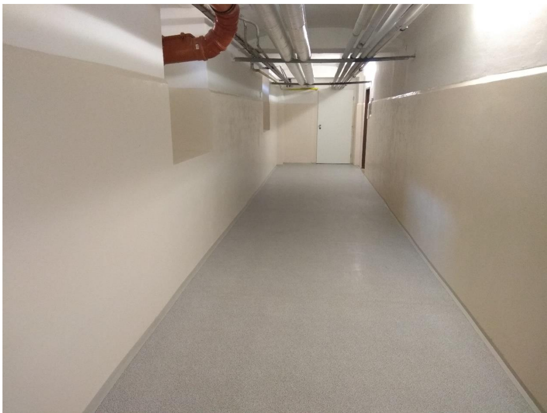
Opravená chodba k šatnám
