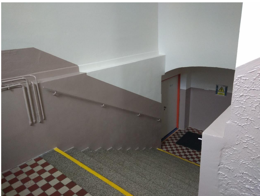
Rekonstruované vstupy do šaten
