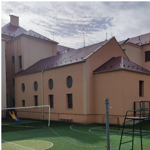
Nový nátěr celé střechy
