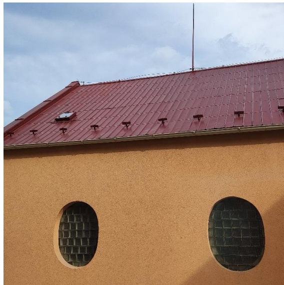
Detail nátěru střechy
